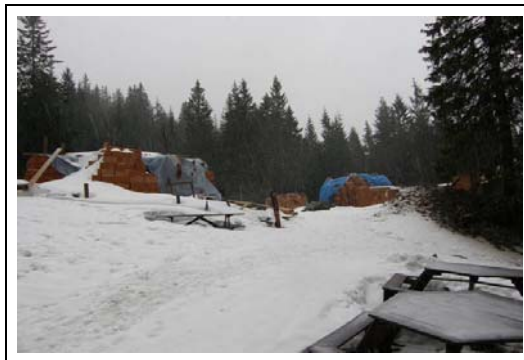
plac budowy na Markowych Szczawinach
