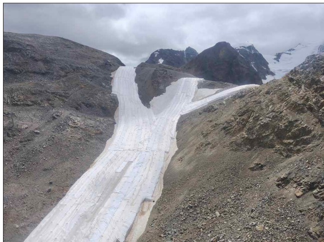
Osłony z geowłókniny osłaniające resztki sniegu na nartostradzie
